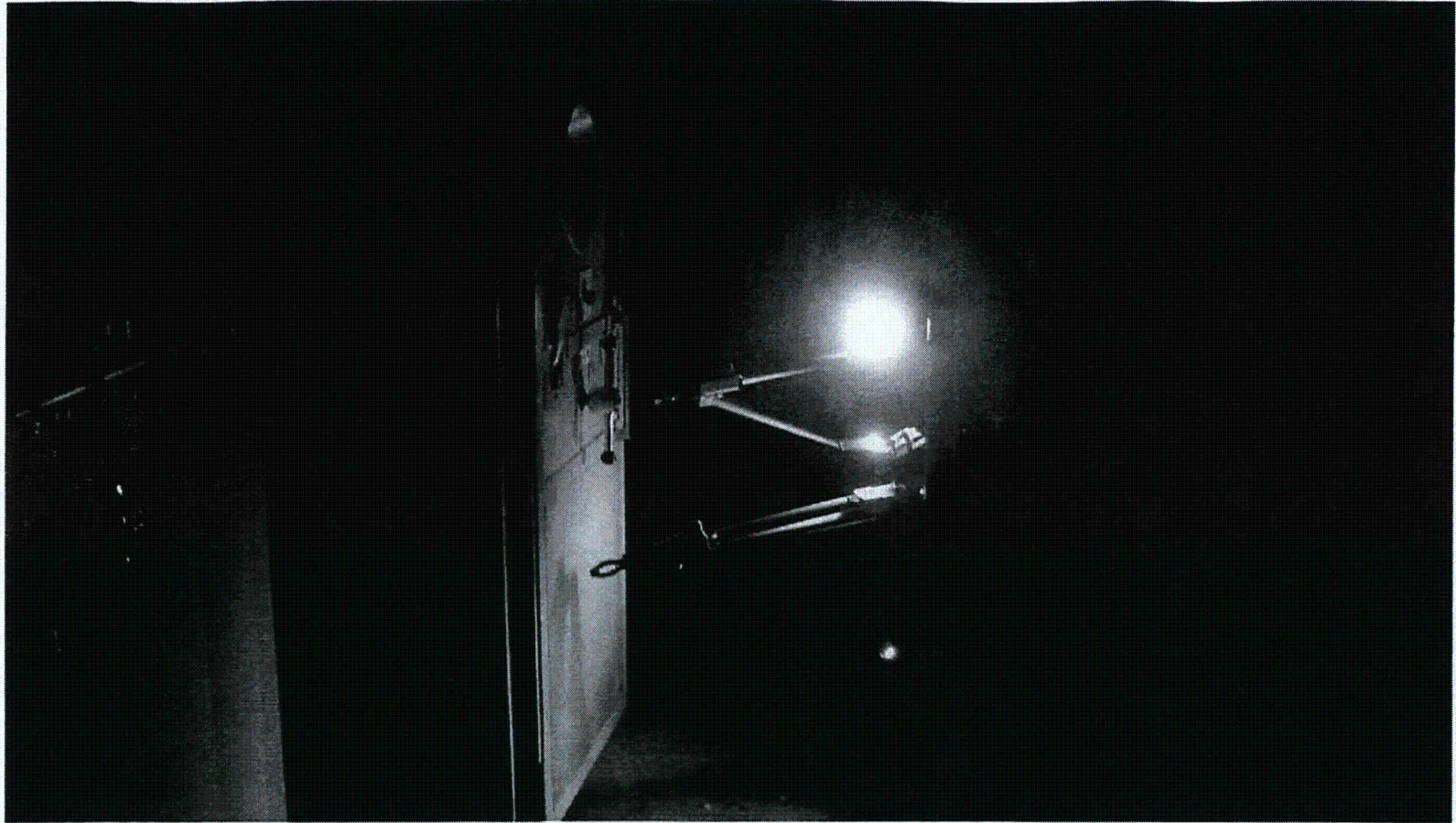
パックボットが二重扉を開ける様子③
