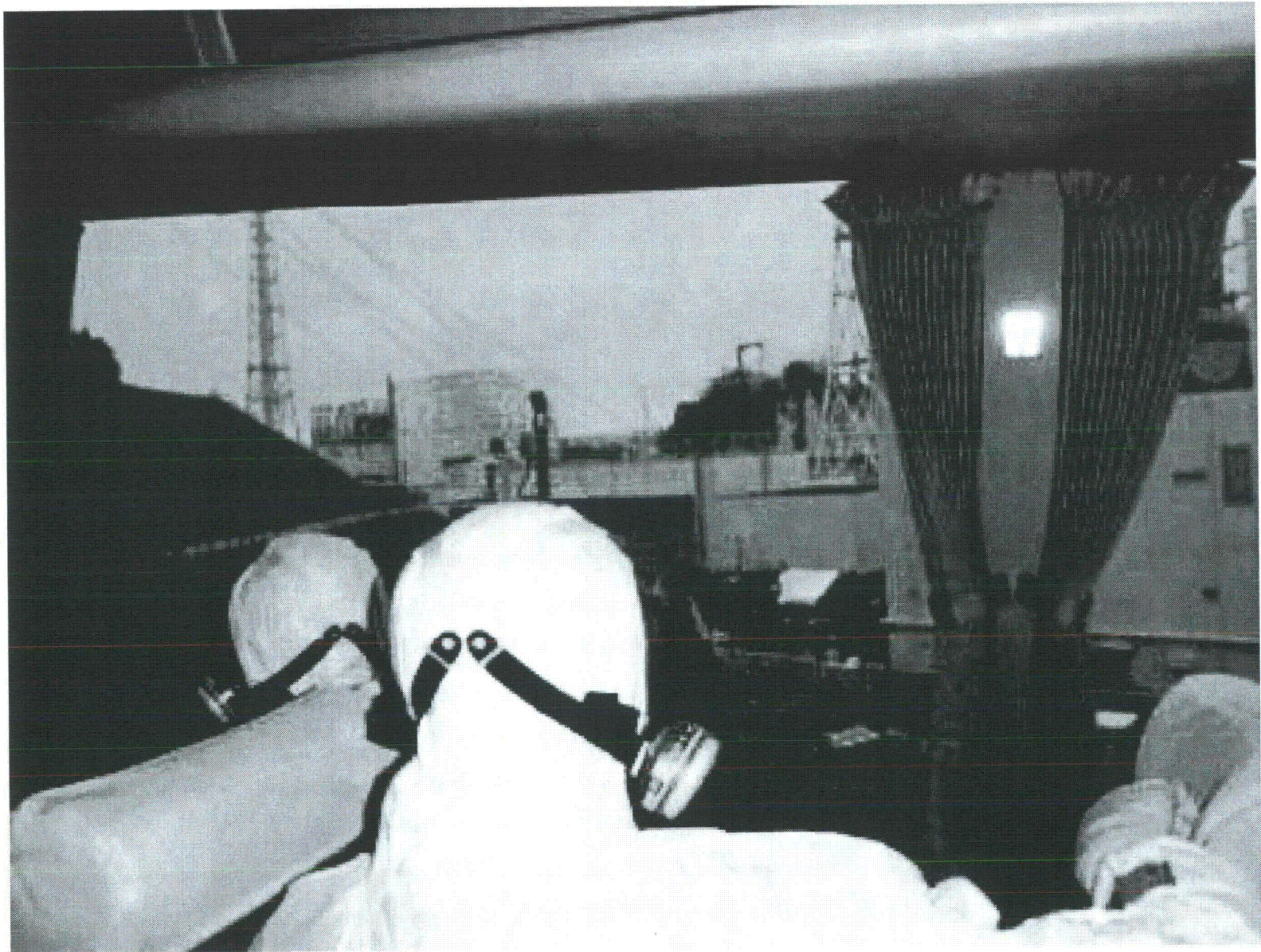
(6)現場視察4(1～3号機を望む)
