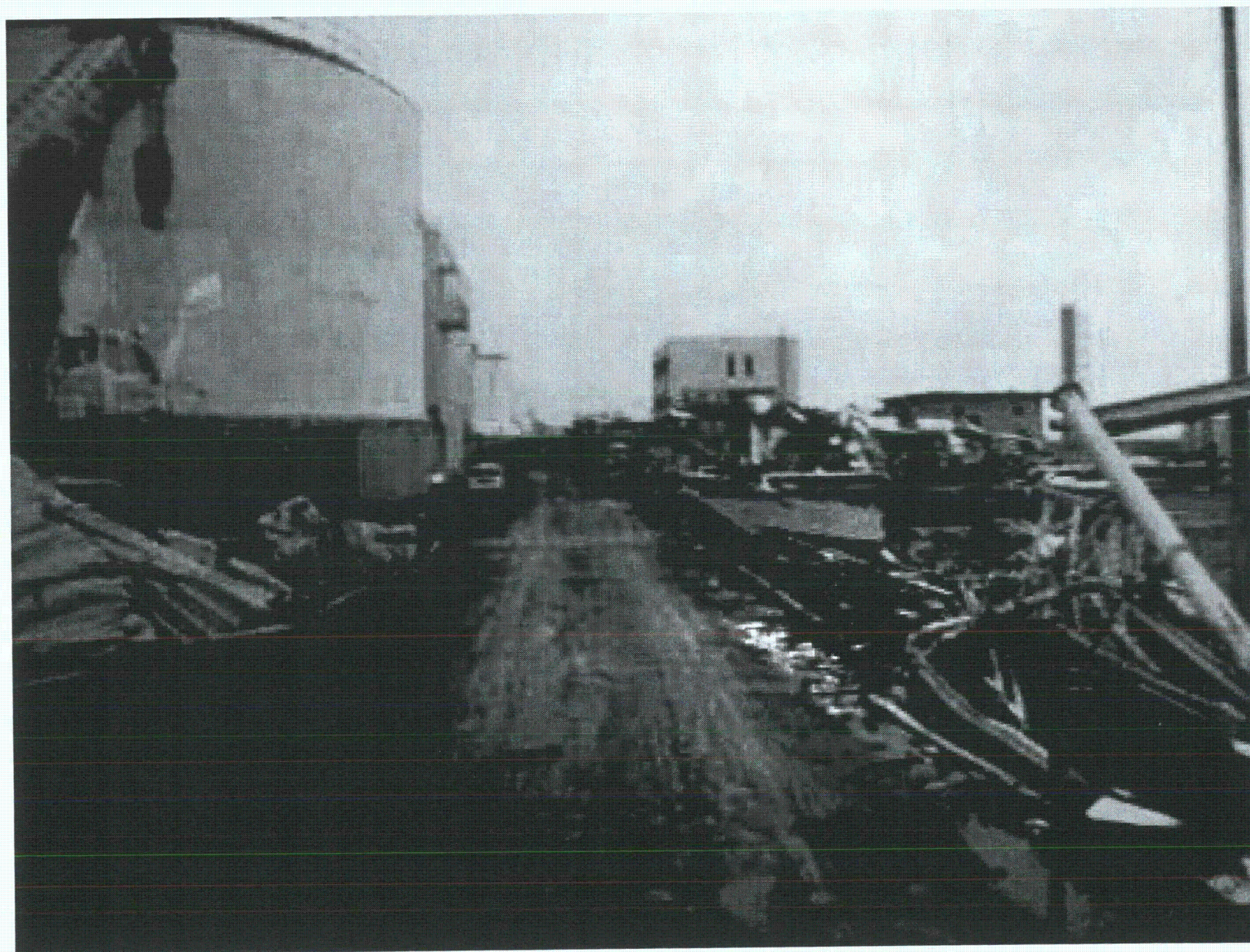
(4)現場視察2(4号機前から1～3号機を望む)
