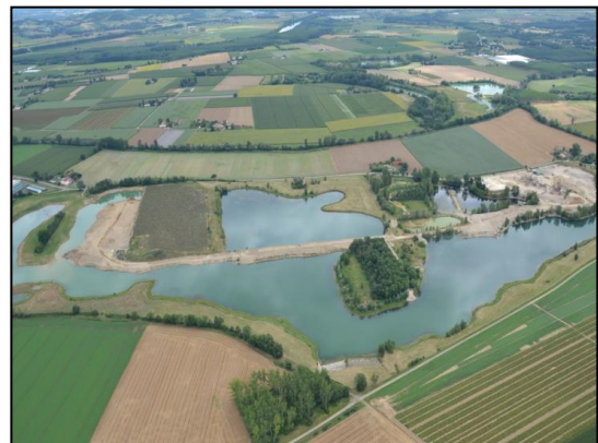
Photo 19 : Exploitation de granulats (au premier plan, la gravière de Lagruère ; au second à droite, la RNN)
