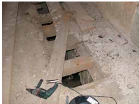
Photo 2 : prélèvement sur une solive du plafond du RDC
