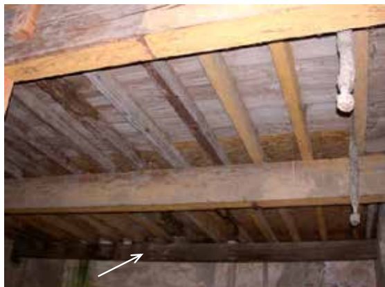
Photo 1 : plafond du 1 er étage
