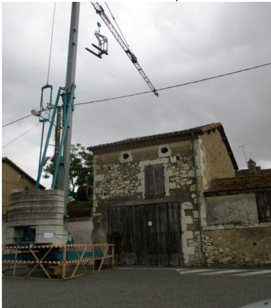
Les travaux vont débuter rue de Metz, la grue est installée./ Photo DDM, F. C.
