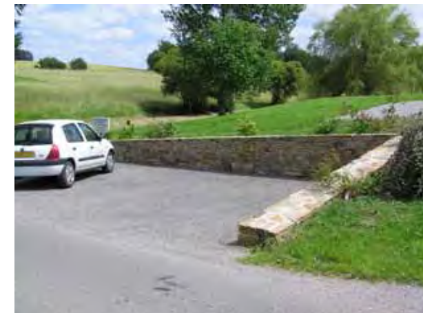
Soigner l'aménagement des aires de stationnement à proximité des sites : utilisation de matériaux simples appartenant au paysage en place : mur de pierre, enherbement, arbres.
