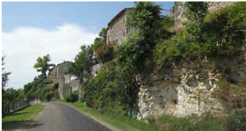
Gérer la végétation pour ne pas masquer le site du village et révéler la ligne des remparts. Castéra-Lectourois
