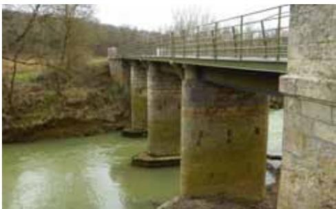
Pont à structure mixte, pierre et métal. Le garde-corps a été rénové dans le respect du style d'origine. Pergain-Taillac
