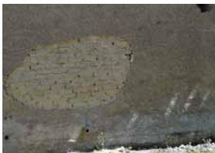
Les briques de terre crue apparaissent sous l'enduit qui s'est dégradé. Fleurance
