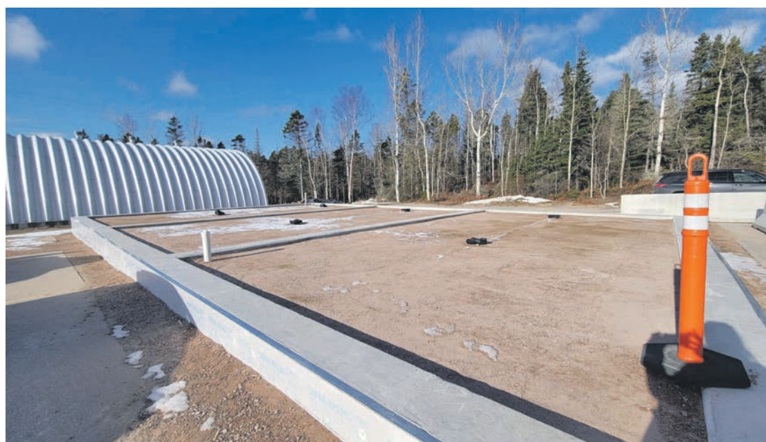
Une serre quatre saisons à trois sections indépendantes a déjà commencé à être construite. Photo Anne-Sophie Paquet-T
