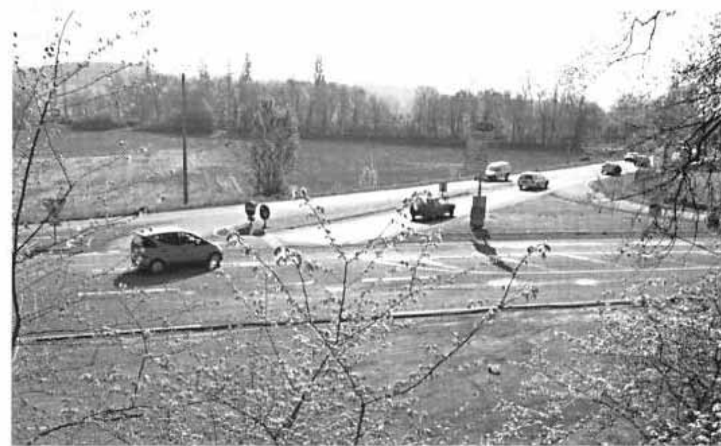
Les travaux du carrefour d'Auch-Pavie achevés en septembre.
