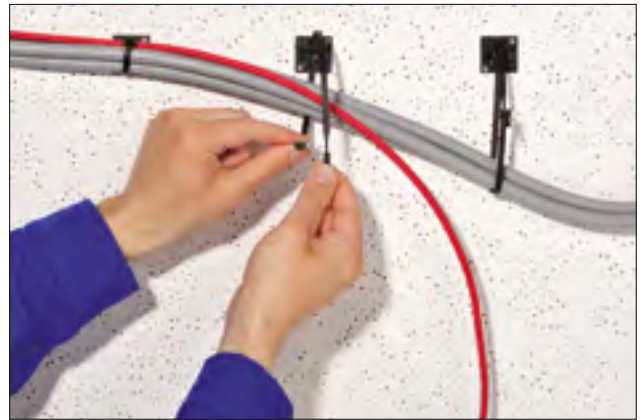
Sadece Q-tie serisi, ek işlem gerektirmeksizin geçici ve son bağlama için kullanılabilir.
