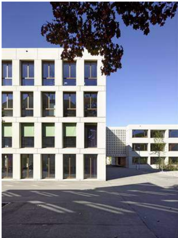
Zehntenhofschulhaus Wettingen: Sichtbeton und Holz.
