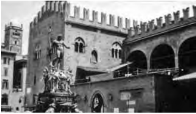
Figure 300. Palazzo del Podestà in Bologna, restored by A. Rubbiani
