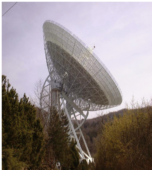
Figura 2.7: Antena de 100m de Effelsberg
