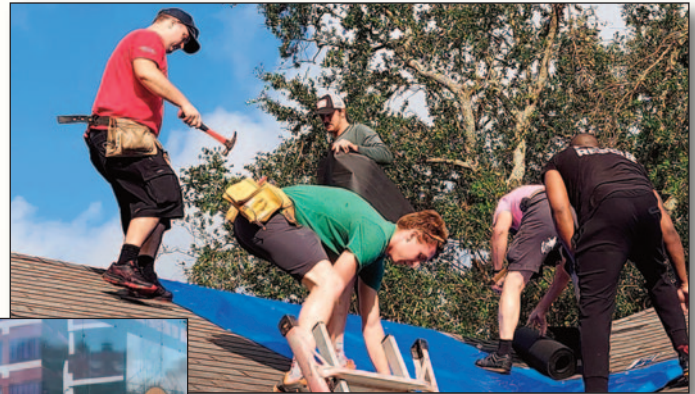
Les équipes des membres de l'AIP travaillent à fixer des bâches sur les maisons des membres de la Louisiane, afin d'éviter d'autres dommages jusqu'à ce que des réparations permanentes soient effectuées.
