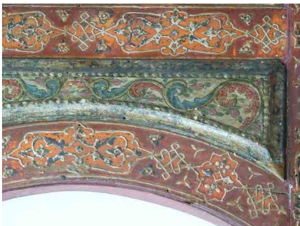
Abb. 695: Gewölbtes Paneel oberhalb einer Wandnische
