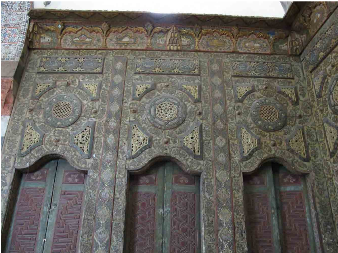
Abb. 654: Südwand des westlichen ʿazar
