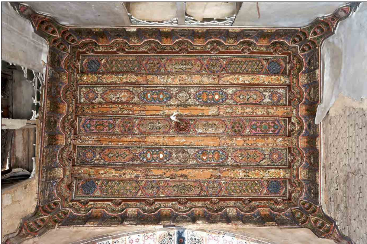
Abb. 631: 'ataba -Decke des Zimmers östlich des ṭwān im inneren Hof
