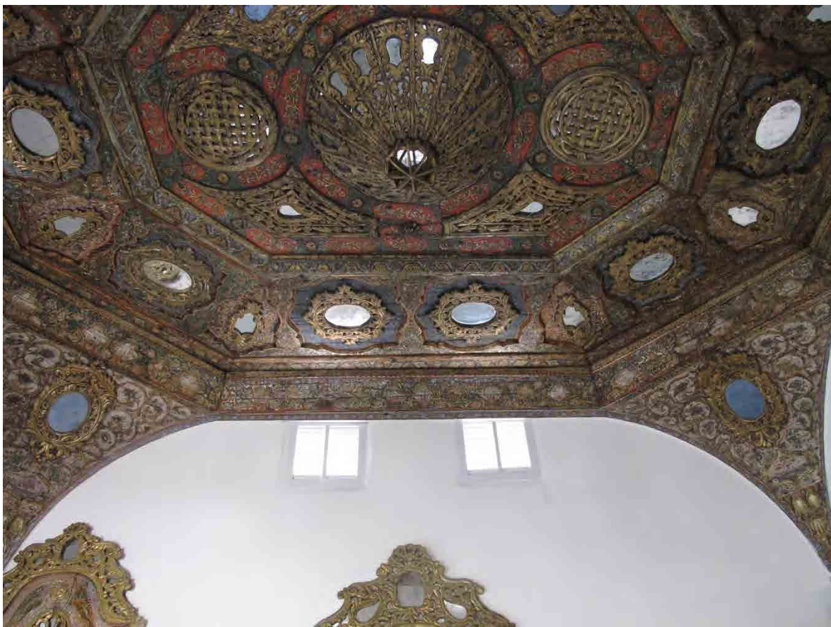
Abb. 706: Ausschnitt der Decke Richtung Westen
