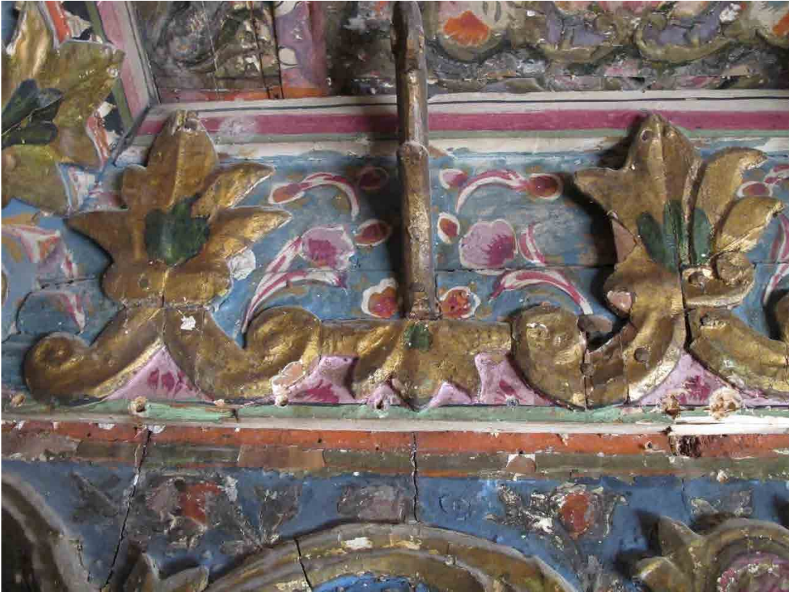
Abb. 676: NW- qā'a , datiert 1238 H / 1822-23 AD, Deckengesims, NO-Ecke des ṭazar
