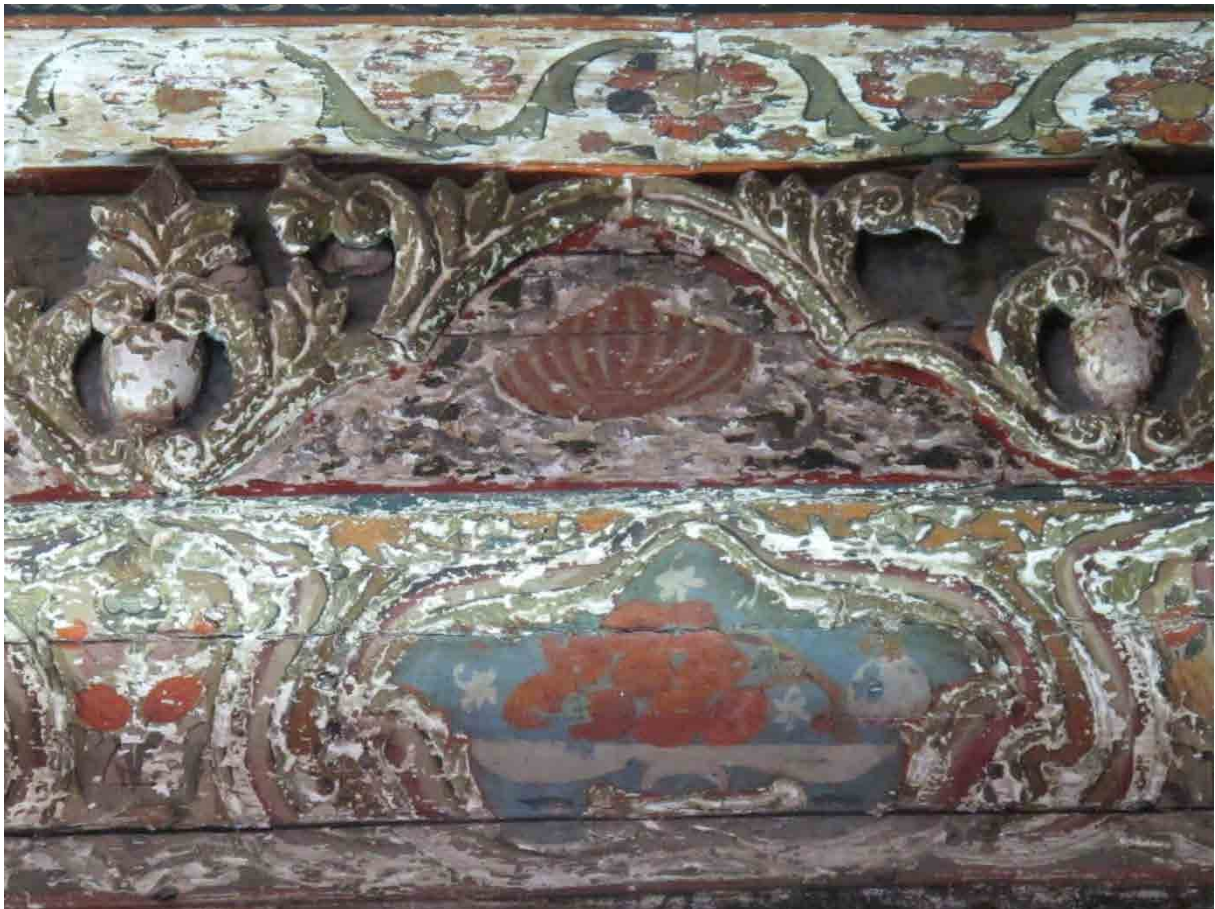
Abb. 673: Detail des Gesimses, țazar -Südwand
