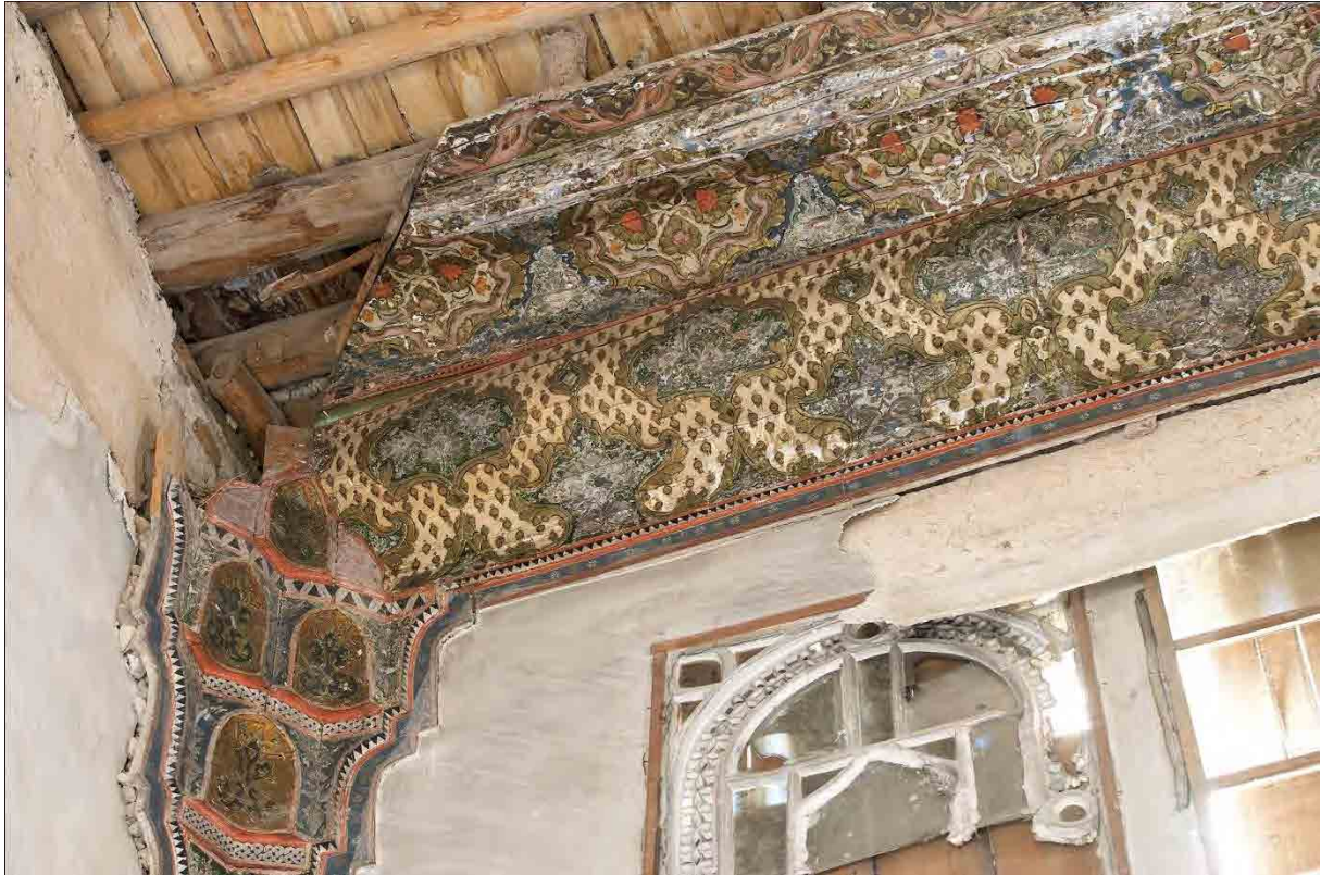
Abb. 645: Südostecke des Deckengesimses im östlichen tazar mit Resten des originalen Gips-Glas-Fensters
