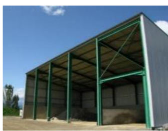
Bâtiment de stockage
