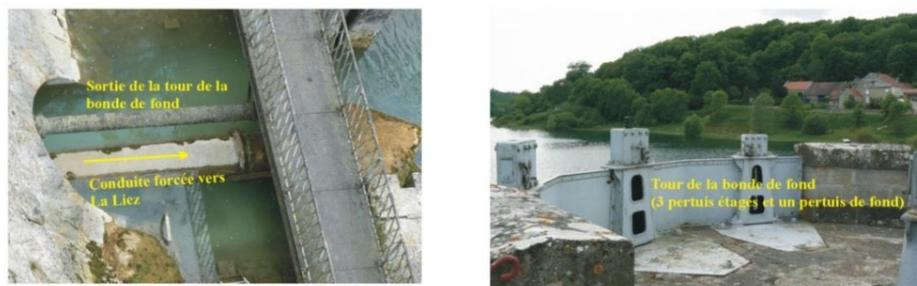
Figure 19 : Photographies des ouvrages hydrauliques du réservoir de la Mouche
