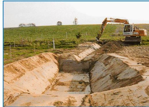
Figure 30 : Exemple de bassins de décantation
