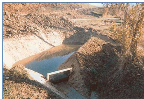
Figure 28 : Exemple de filtre à fine
