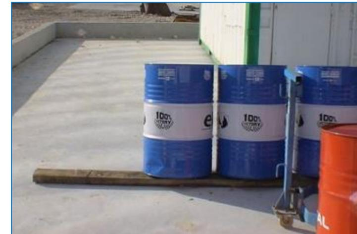
Figure 29 : Exemple de zone de stockage imperméabilisée
