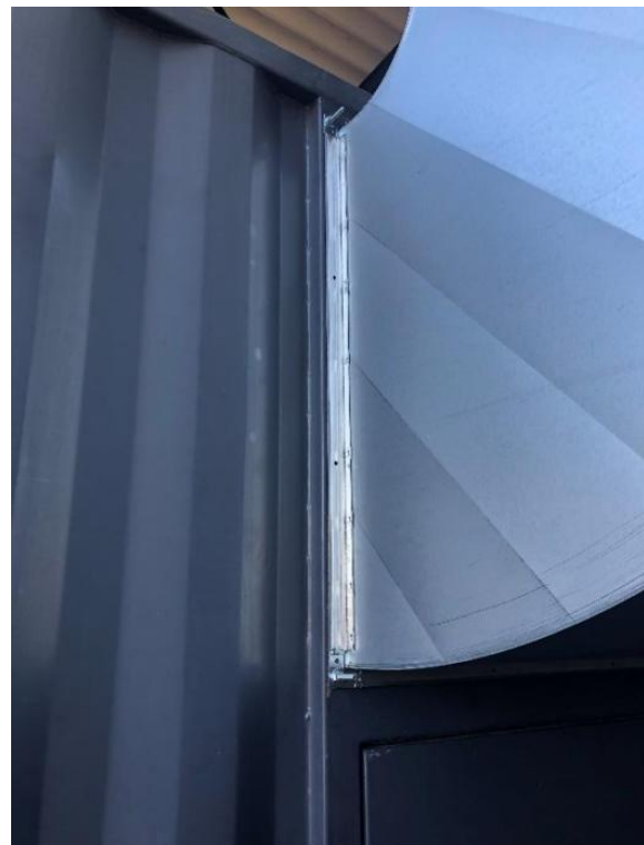
Dispositif de réduction de bruit pour les groupes électrogènes du site de POWER SOLUTIONS
