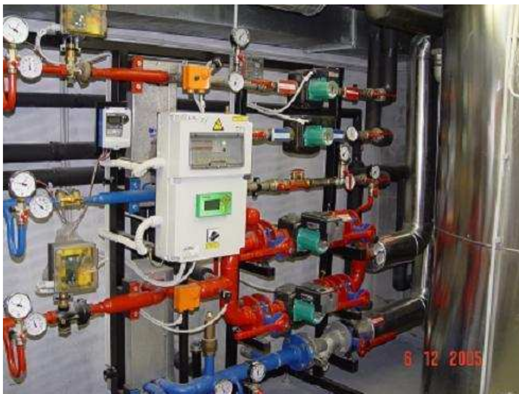
Slika 13: Indirektna toplotna postaja v bloku
