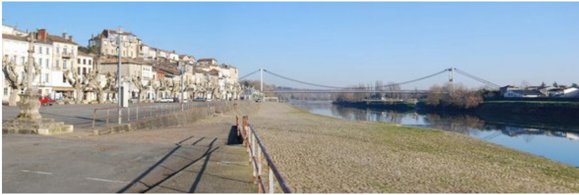
Le vaste parking dévalorise le patrimoine des quais - La Réole crédits : Agence Folléa-Gautier
