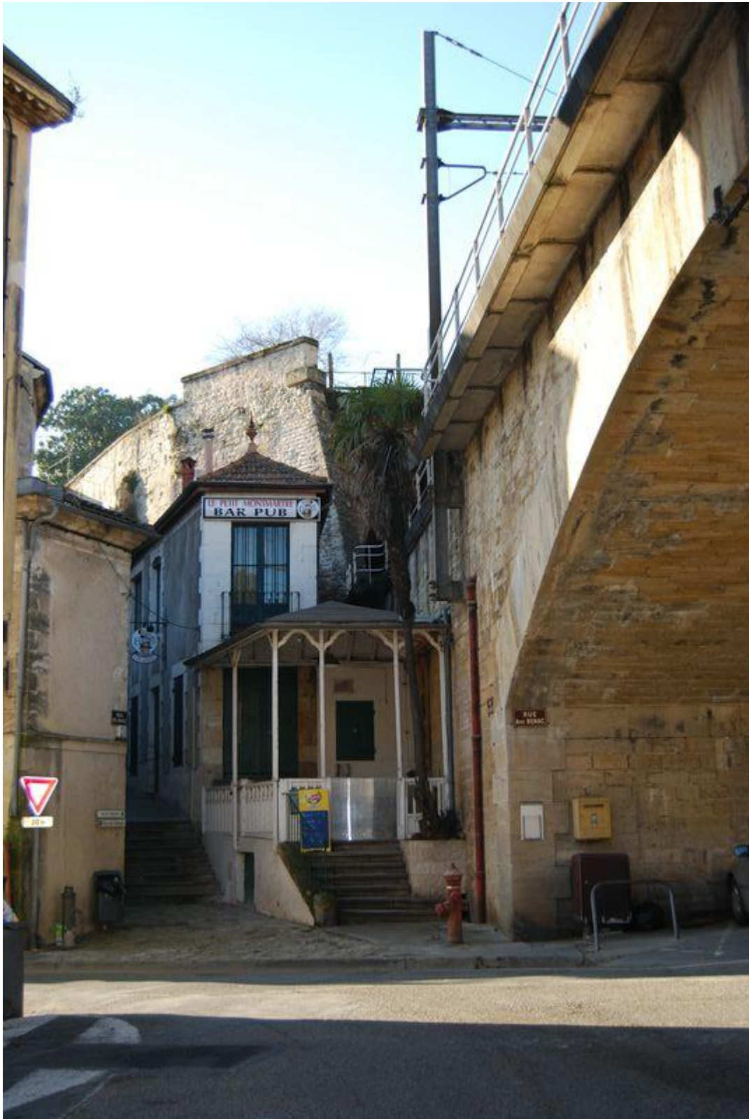
Franchissement sous le viaduc de la voie ferrée - La réole crédits : Agence Folléa-Gautier
