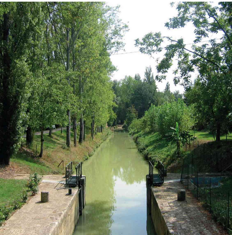
Amont de l'écluse d'Autiège sur la Baise navigable à Condom
