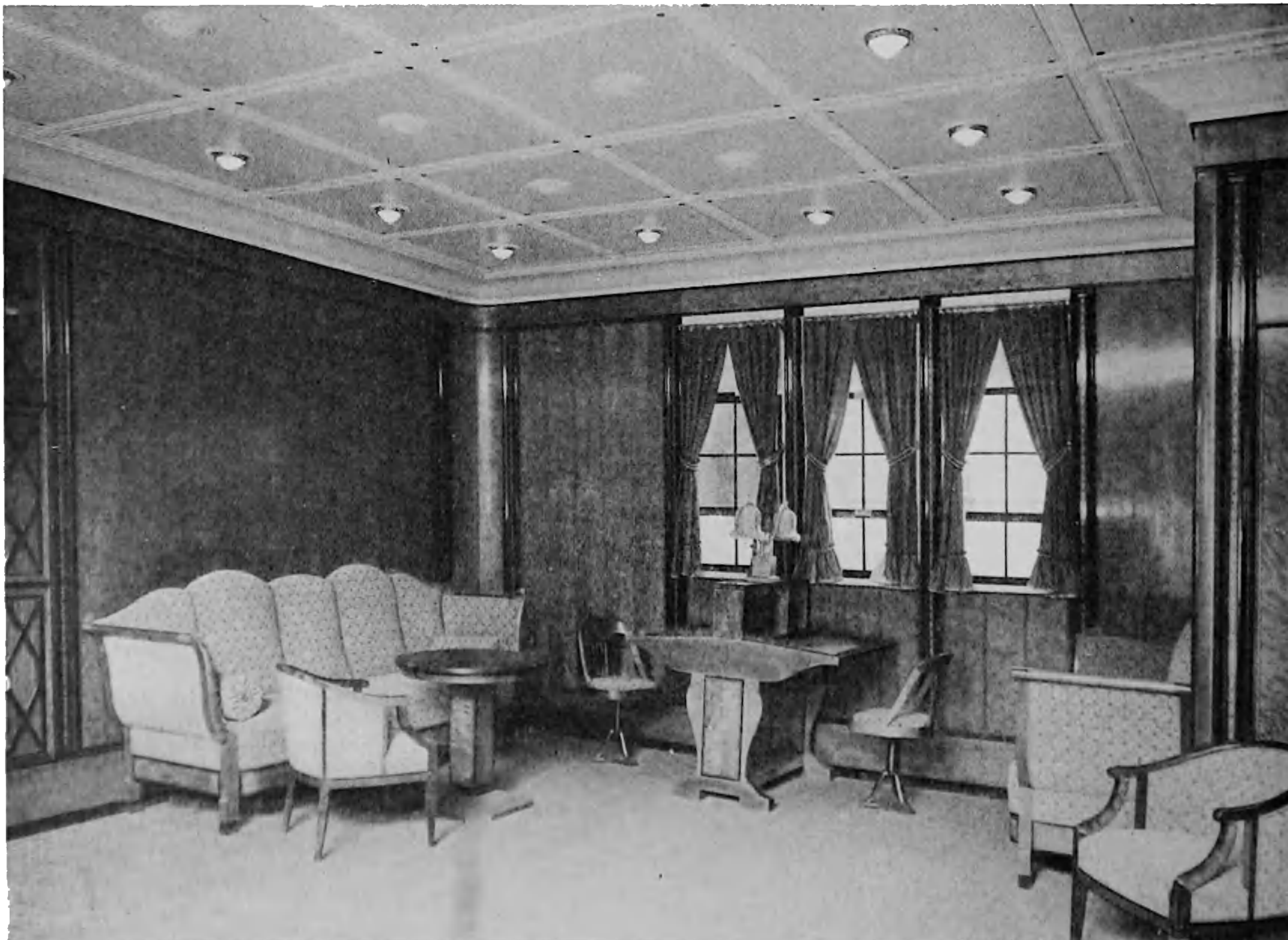
READING ROOM ON THE NORDDEUTSCHER LLOYD SS. "GEORGE WASHINGTON." DESIGNED BY PROF BRUNO PAUL EXECUTED BY THE VEREINIGTE WERKSTÄTTEN FÜR KUNST IM HANDWERK, A.G., MUNICH AND BREMEN
