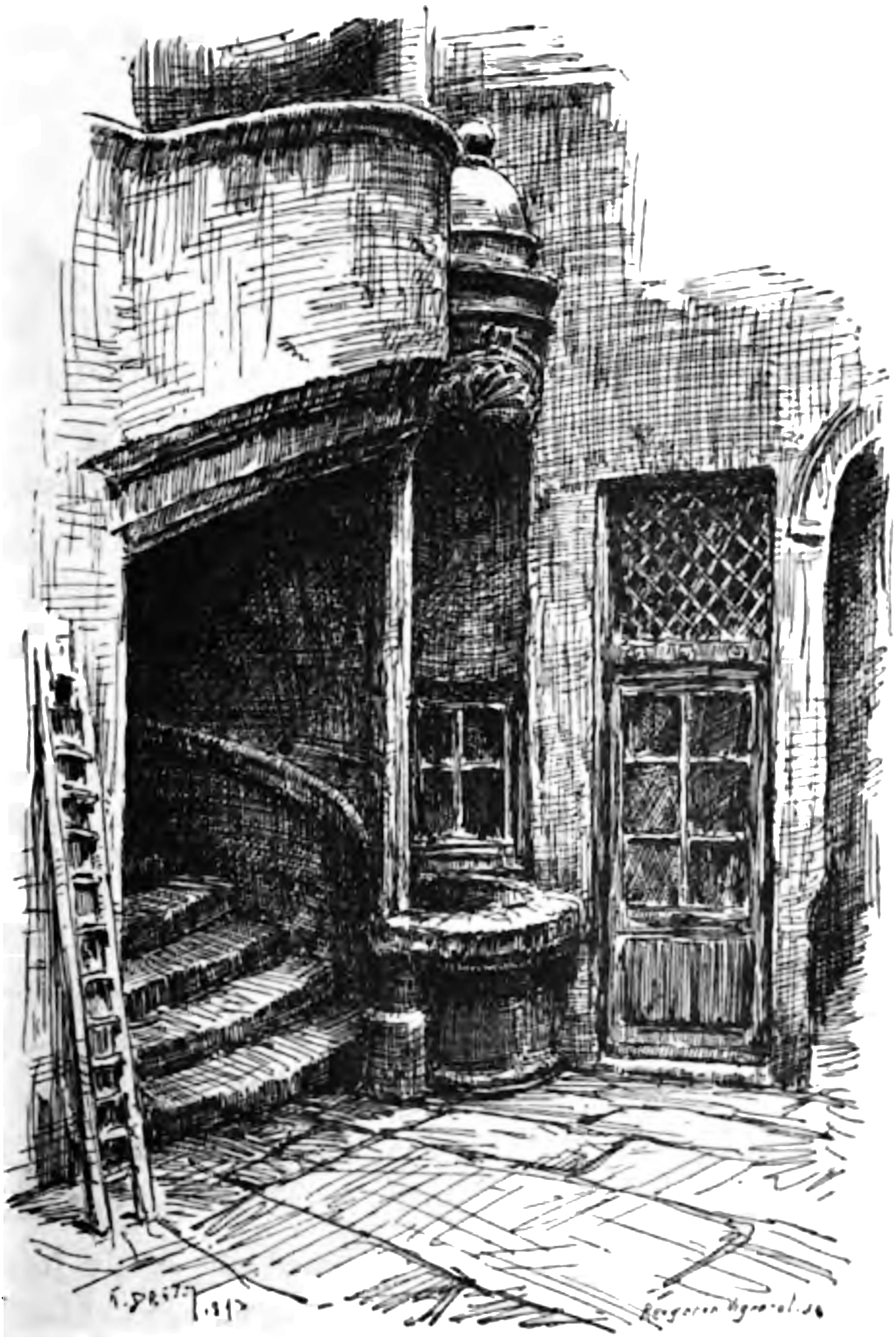
Escalier et puits rue Saint-Jean, n° 46.
