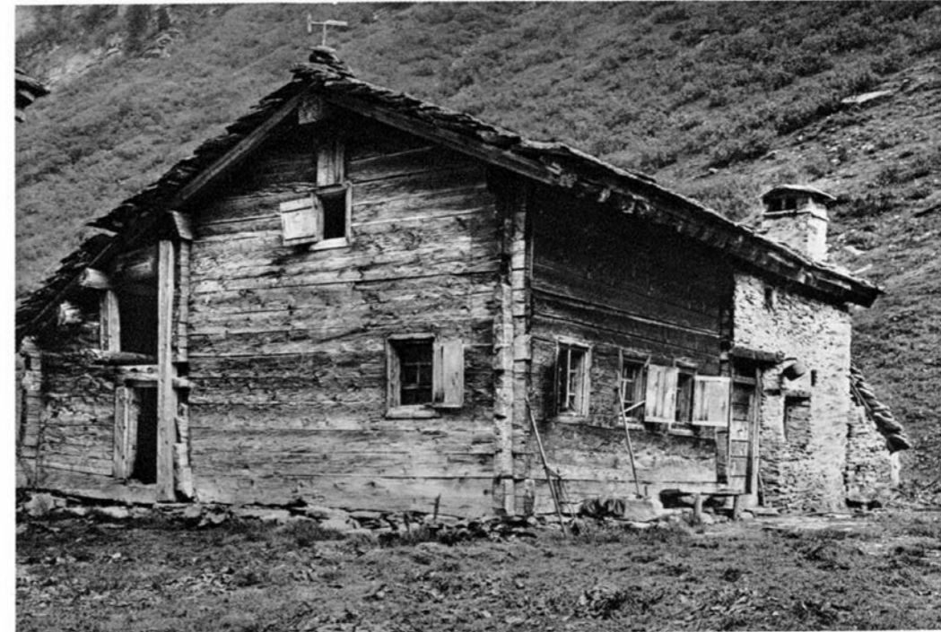
120. La « Maison de Païens » à Zervraïla. Comme la maison du Gothard, la cuisine maçonnée sur le derrière, et le devant tout bois. Datée de 1563. L'étable à gauche est une annexe récente.
