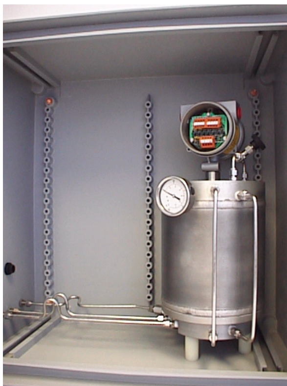
Figure 1-1 Vue du transducteur de densité modèle 3098 installé dans une enceinte type
