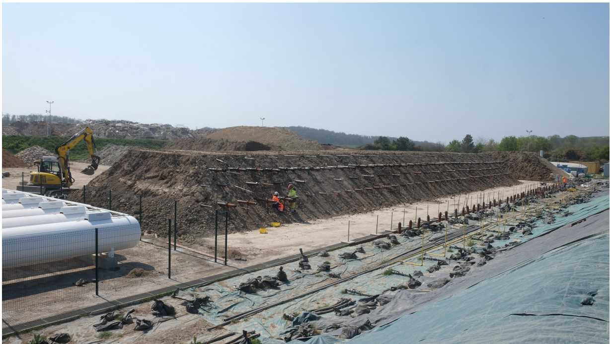
Prise de vue : Aire de traitement n° 7 (à gauche)
