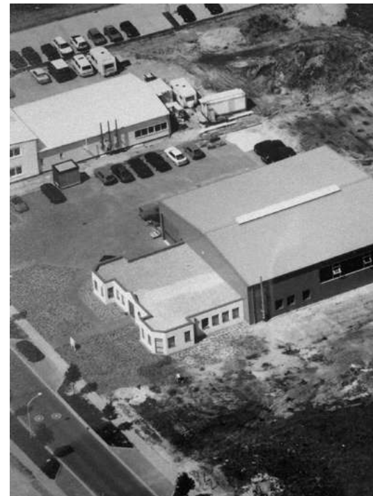
Nouveau bâtiment à Achim de 1000 m 2 d'atelier et 300 m 2 de bureaux.
