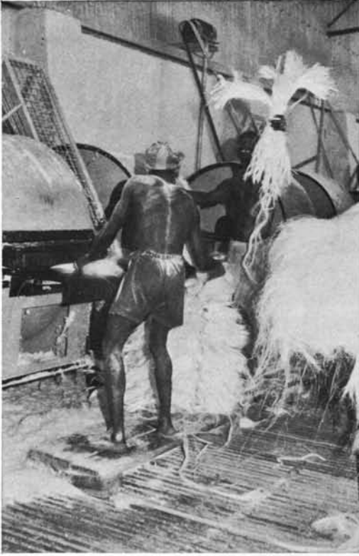
Faserbürstmaschinen veredeln die getrockneten Sisalfasern und bedecken die schwarzen Körper der Arbeiter mit weißem Staub.
