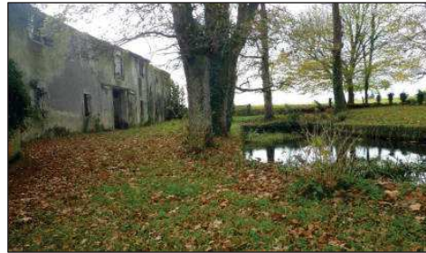
Construction abandonnée et réservoir de stockage
