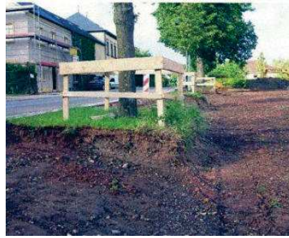
Arbres protégés par des barrières en bois
