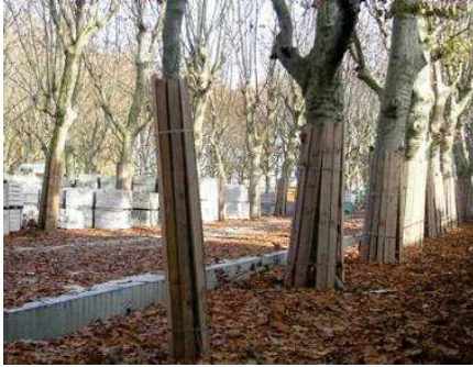
Arbres protégés par un câble enroulé autour du tronc, sur lequel s'appuie un habillage de bois
