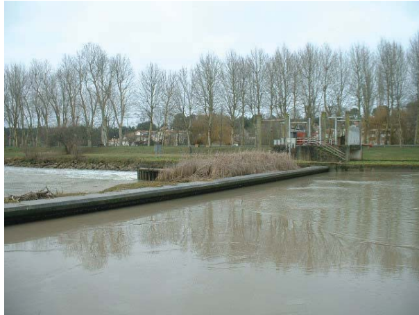
Photo 1 : Seuil fixe et clapet mobile.
