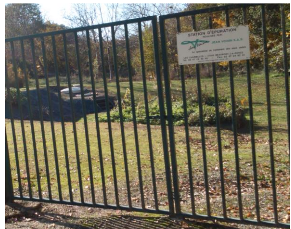
Station d'épuration : entrée
