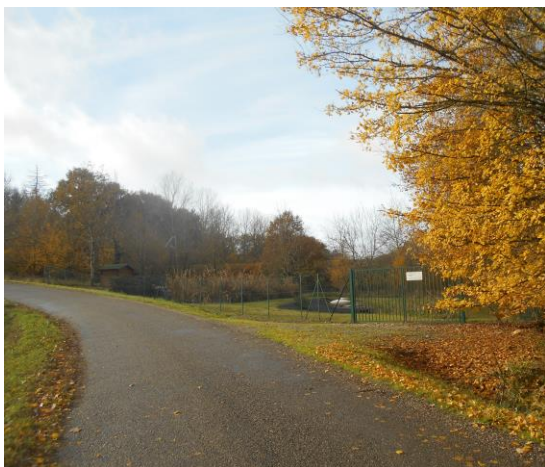
Station d'épuration :vue générale
