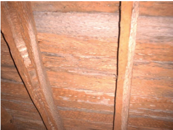
FOTO N° 257: Trichocereus atacamensis , es utilizado para la construcción de cielorrasos. San Antonio del Cajón. Dpto. Santa María.
