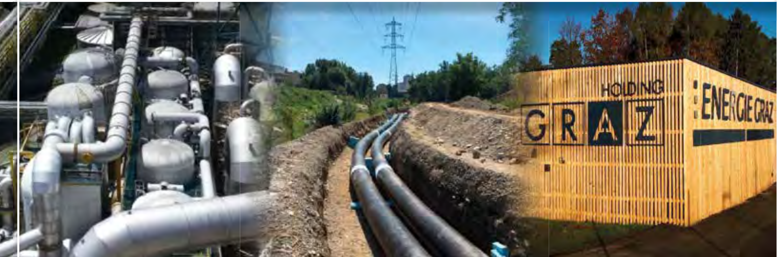
Eindampfanlage Papierfabrik Sappi
