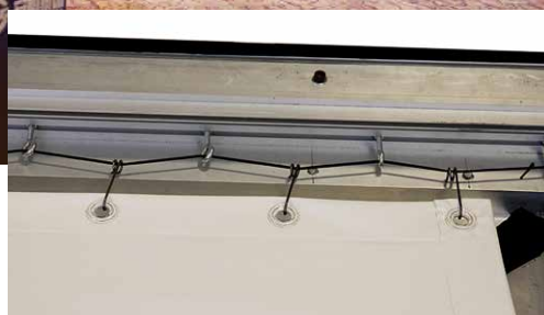
Système de tension de la toile
