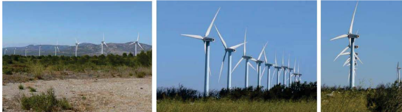
Photographie 33 : Perception selon l'angle de vue (Source : The Wind Power, auteur : Michaël Pierrot)
