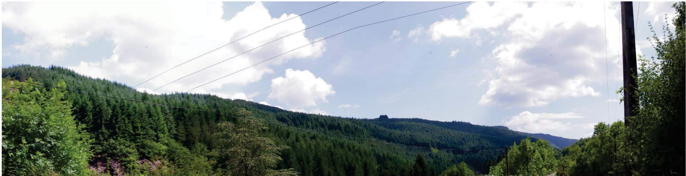
Vue sur l'état initial
