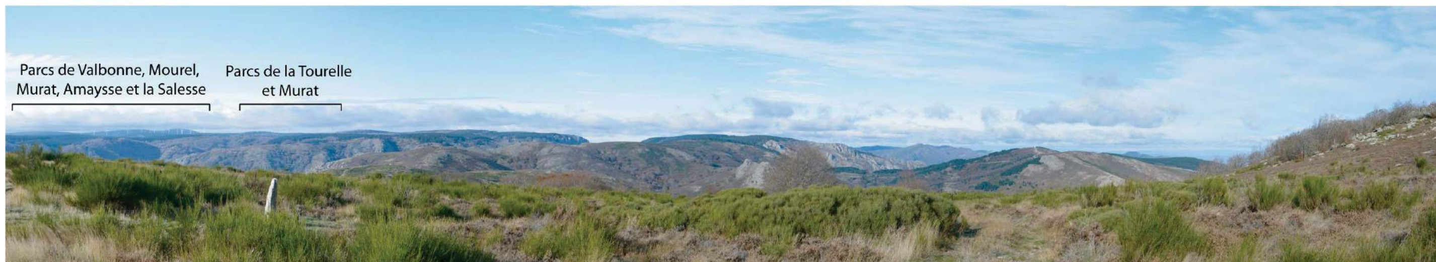
Vue sur l'état initial
