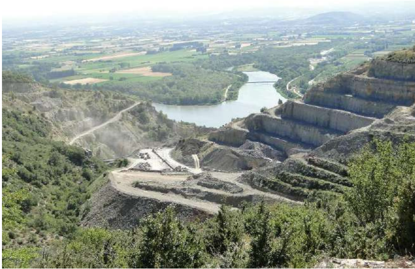
Carrière de Le Pouzin exploitée par Lafarge Granulats, vue du plateau de Rompon (© Biotope, 2012)
