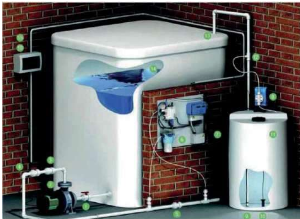
Control y Dosificación mediante Panel Analizador y Bomba Dosificadora
