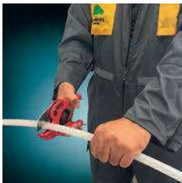
1. CORTAR LA TUBERÍA RECTA
