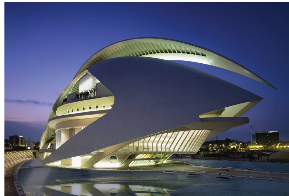
Figure 10: Palais des arts, construit en 2003
