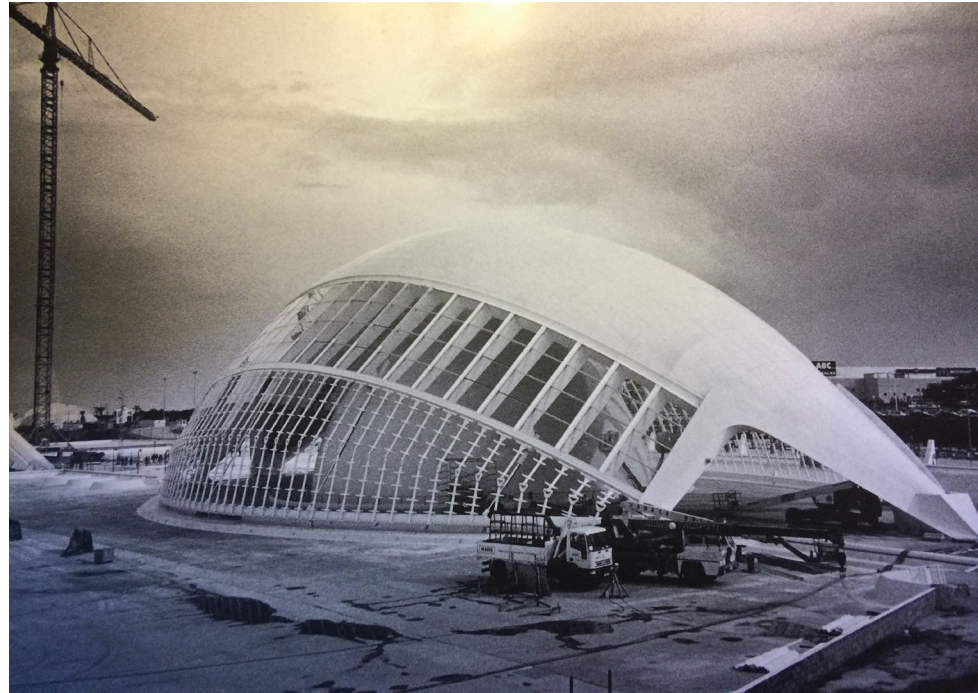
Figure 25 : Hémisphère en phase de construction
