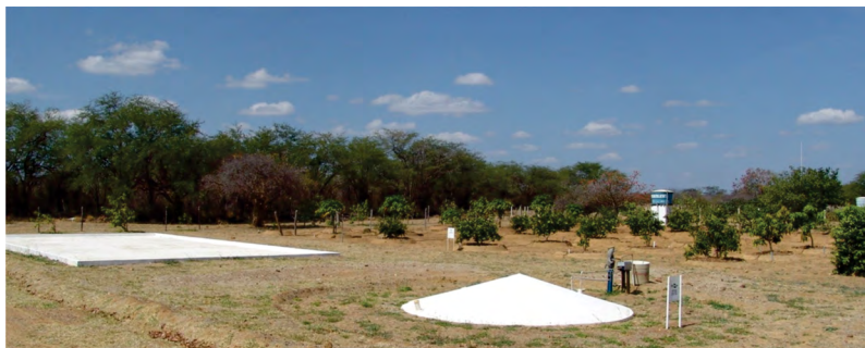
Figura 1 – Cisterna calçada, área de captação e pomar instalados na área experimental da Embrapa Semiárido
