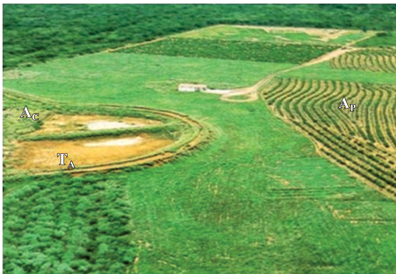
Figura 1 – Barreiro para uso em irrigação de salvação de culturais anuais
