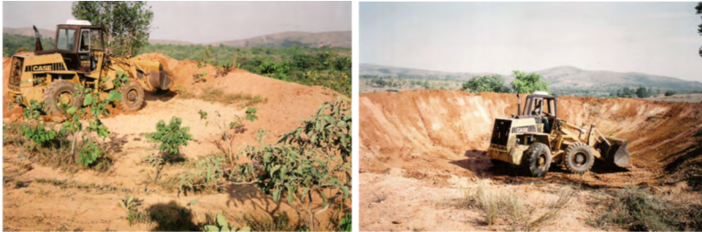
Figura 4 – Barraginha sendo desassoreada (esquerda) e Manutenção da Barraginha concluída (direita)
