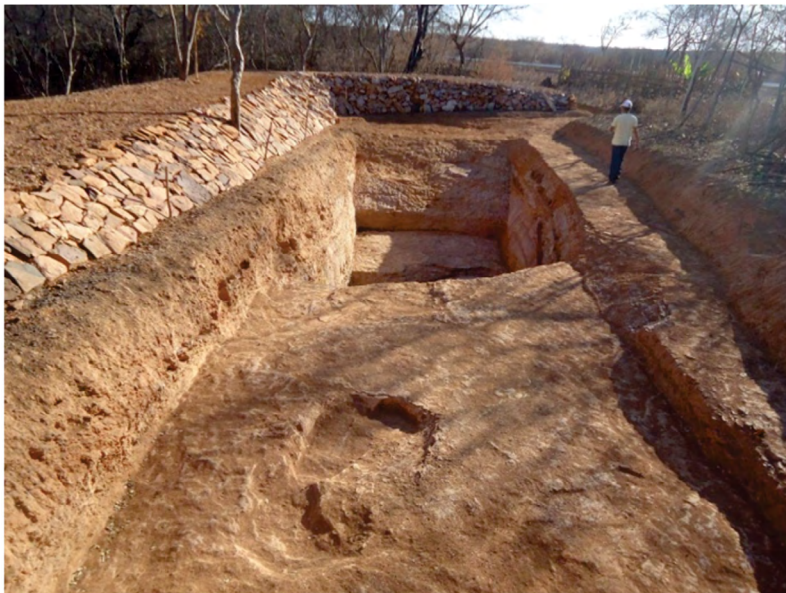
Figura 3 – Caxio. Comunidade Tanque de Terra, Vera Mendes, Piauí/Construção manual, com recursos do Pronaf Semiárido.
