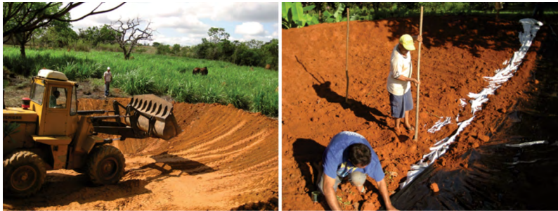
Figura 21 – Construção do lago de múltiplo uso (esquerda). Construção do lago de múltiplo uso (direita)
