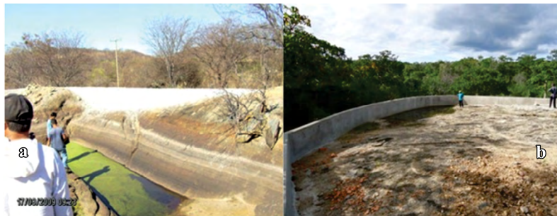
Figura 4 – Modelos de tanque de pedra de acordo com o formato da rocha: a- formato de concha ou fenda (comunidade Poço Dantas, município de Porteirinha/MG); b- rocha com superfície plana (lajedo), paredes do tanque de pedra reforçadas (Comunidade São Miguel, município Júlio Borges/PI)
