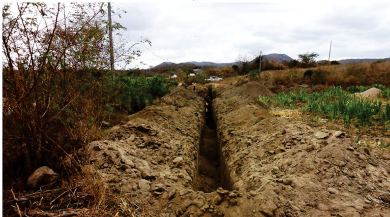
Figura 13 – (A) Vala da parede aberta; (B) Plástico estendido formando a parede/septo impermeável; (C) Detalhe do sangradouro pronto e vala fechada com plástico enterrado, formando a parede/septo impermeável; (D) Barragem subterrânea em produção com poço construído a sua montante.
