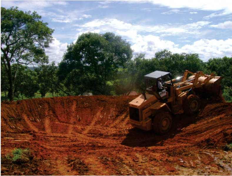
Figura 3 – Barraginha em construção
