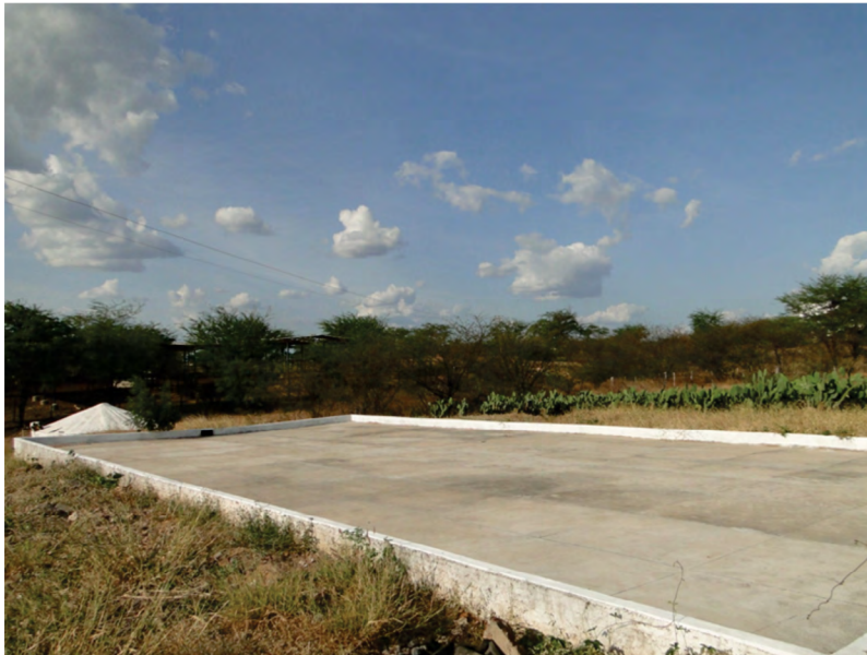
Figura 5 – Sistema calçadão e cisterna para irrigação de 0,2 ha de palma adensada
