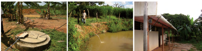
Figura 22 – a) Abastecimento do lago por cisterna (imagens à esquerda e do centro). b) Abastecimento do lago por cisterna (imagens à esquerda e do centro). c) Abastecimento do lago por cisterna por água de chuva captada por telhado (imagem à direita)
