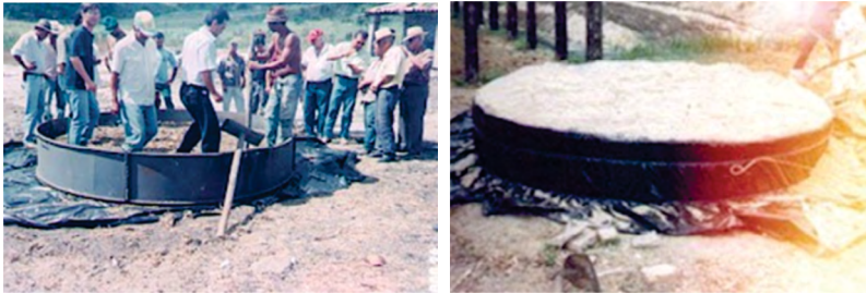
Figura 14 – Enchimento e vedação de um silo cincho
