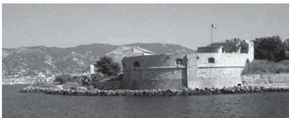
La Tour royale ou Grosse Tour Coupe par Monsieur Verrier, ingénieur du roi vers 1707 et aspect actuel
