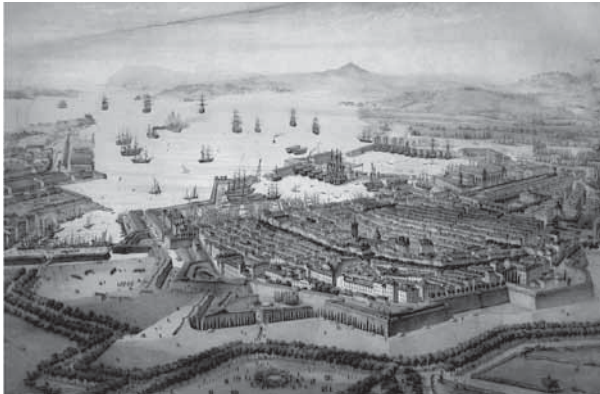
1850 - Toulon et les fortifications du côté est
