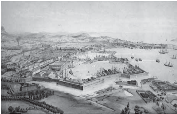
1850 - Toulon et les fortifications du côté ouest
