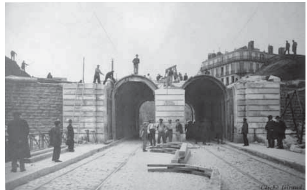
Démolition de la porte Notre-Dame
