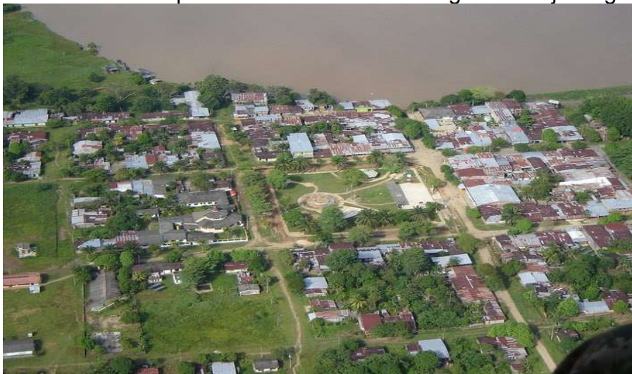
Ilustración 19. Inspección de remolino del Caguán – Bajo Caguán
