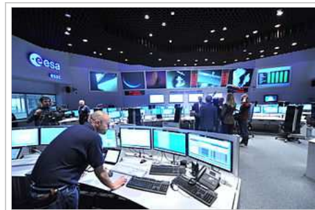
Salle de contrôle principale de l'ESOC.
