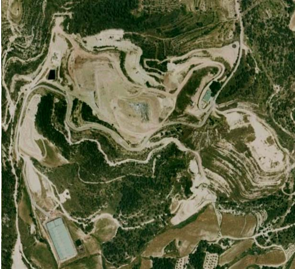
Figura 2.2. Vista satélite del Abocador de Bufalvent.
