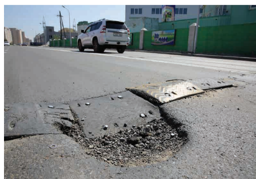
Эдэлгээ даадаггүй хурд сааруулагч замын эвдрэлд багагүй нөлөөлж байна.
