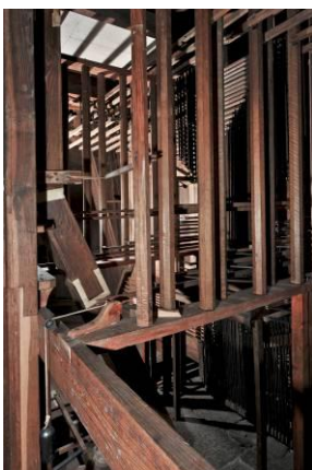
St-Pons. Intérieur du grand-orgue. Partie mécanique
