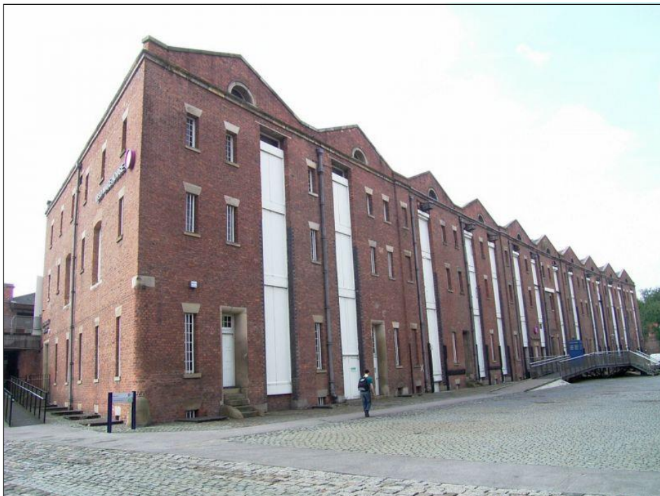
Figure 139 : Les entrepôts de Liverpool Road 574
