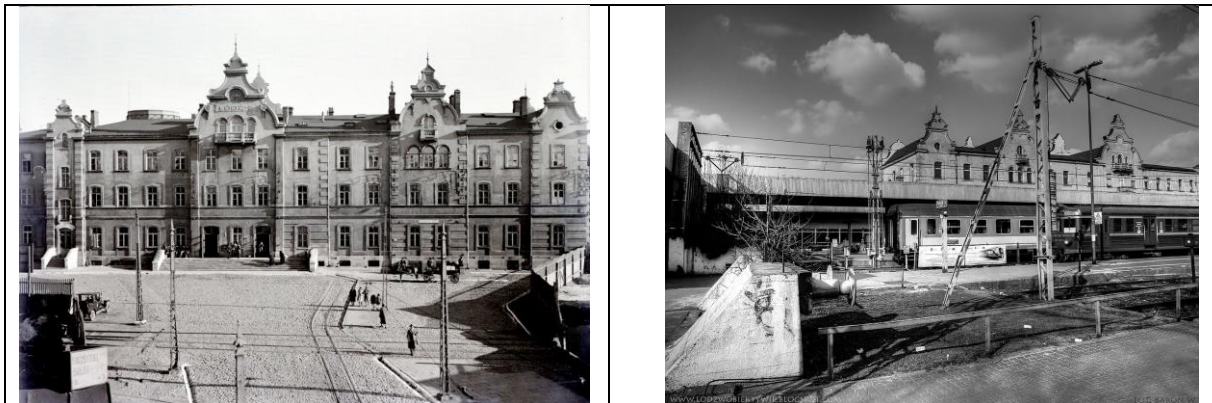
Figure 68 : La gare Łódź-Fabryczna : place extérieure en 1930 357 et quais (non daté) 358
