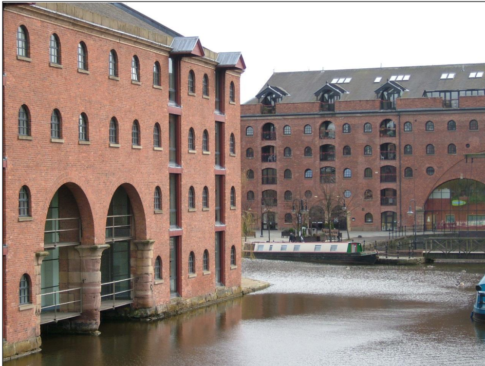
Figure 138 : Castelfield , Merchants' Warehouse (1825) au premier plan et Middle Warehouse (1828-1831) au second plan 573
