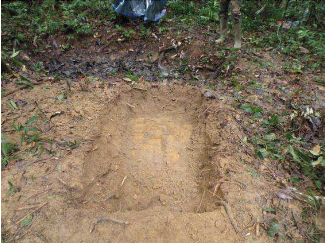
Photo 2-1 : Emplacement de la fosse 2 - djougoun-pétés de 30-40cm en face et à droite
