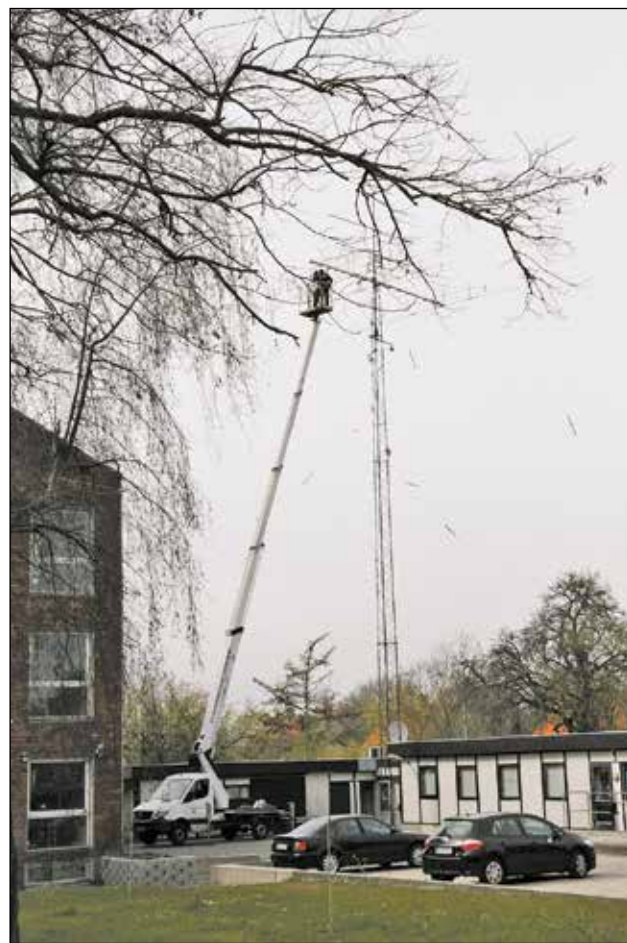
Reparationer på radioamatørernes antennen ved klublokalerne på Tårnby Skole er ikke så lige til. Det kræver kran - her er en sådan reparation fanget engang i 2020. Arkivfoto.
