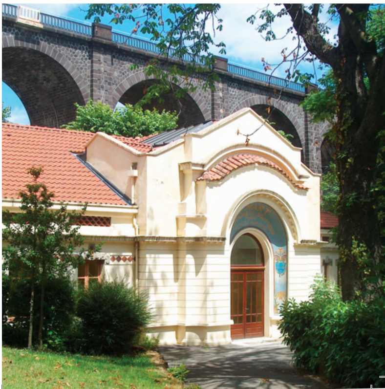
Pavillon Saint-Mart - Parc thermal
