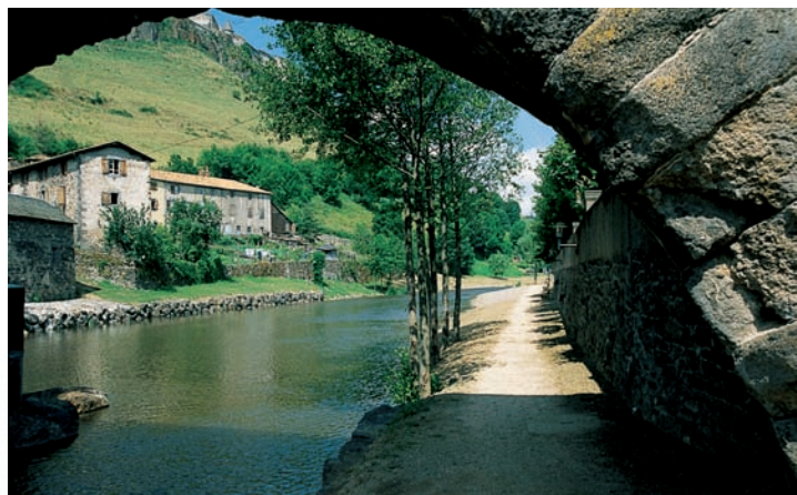
Le Pont Vieux fut reconstruit partiellement en 1404 avec des pierres provenant des maisons des “ faux bourgs ” détruites par les bandes anglo-gasconnes. Pour exécuter ce travail, il fallut détourner le cours de l' Ander .
